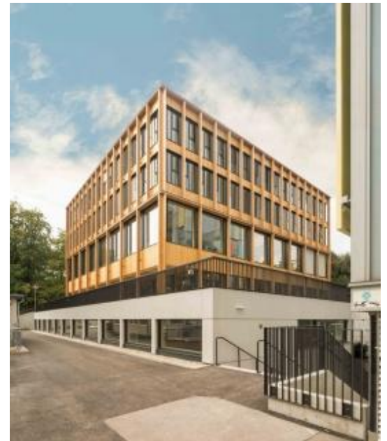
Neben Sockelgeschoss und Stiegenkern in Stahlbeton wurden fast 1000 m 3 Holz verbaut. © Hannes Buchinger
