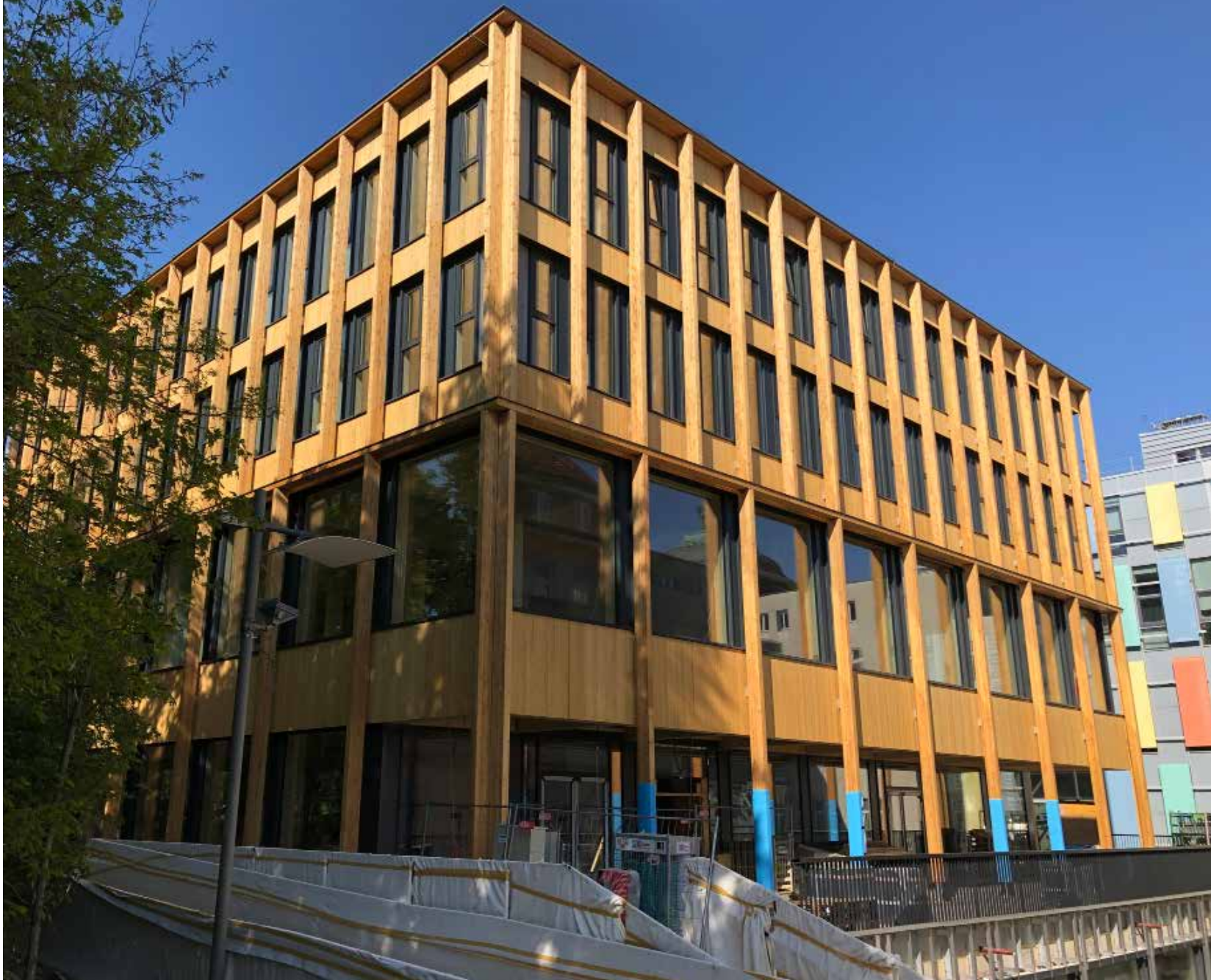
Die Gebäudehülle des BOKU-Neubaus ist Großteils eine Pfostenriegelkonstruktion mit 3-fach-Verglasung. Die Fassade besteht aus unbehandeltem Lärchenholz
